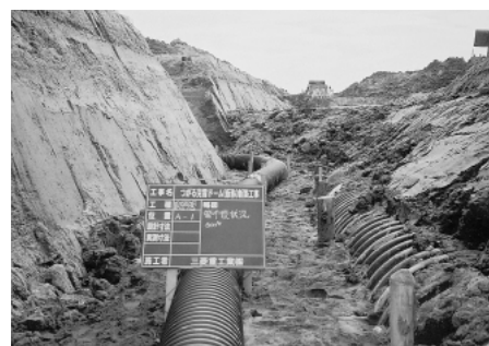
図11 採熱管敷設状況
