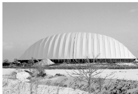
図1 屋根閉時のドーム全景 南側から臨む。
