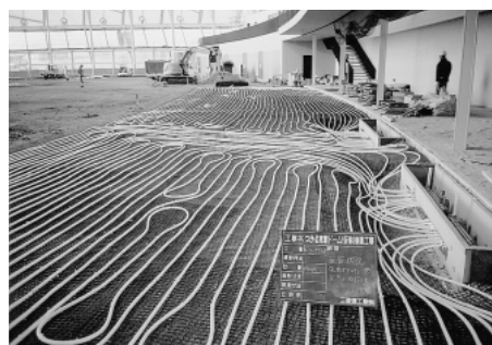
図8 サーマルグラウンド敷設状況
