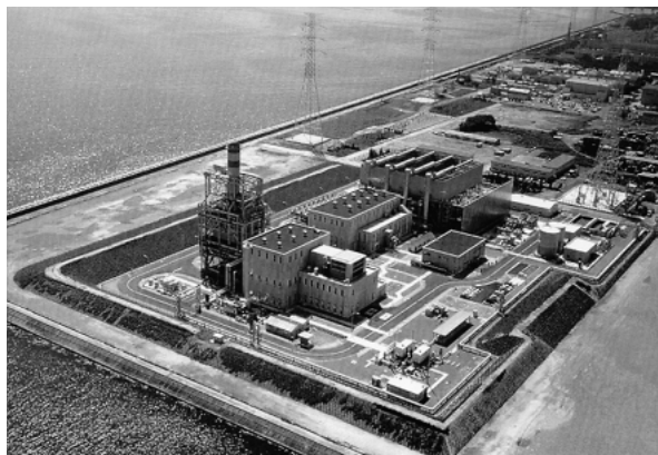
図9 長期信頼性実証設備 H形ガスタービン試運転を行った高砂製作所内実証発電設備を示す。
