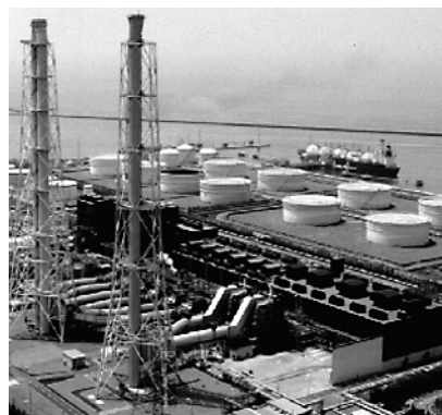
図10 東北電力(株)東新潟火力発電所 東北電力(株)東新潟火力発電所の全景を示す。第41号系列は事業用発電所では世界初のタービン入口ガス温度1450℃級ガスタービンを採用した。
