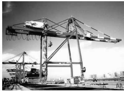
図3 コンテナクレーン
