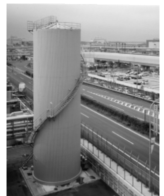
図14 新東京国際空港（成田空港）に設置したPCM蓄熱システム
