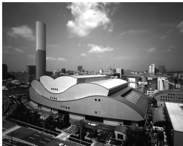
図3 ごみ発電プラント
