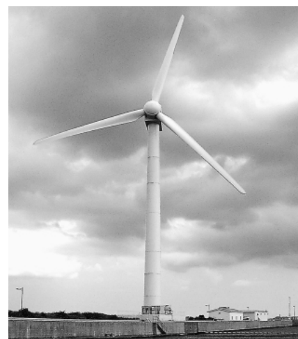
図11 国内初の2000kW風車（沖縄新エネ開発（株）向け MWT-S2000，沖縄県具志川市）
