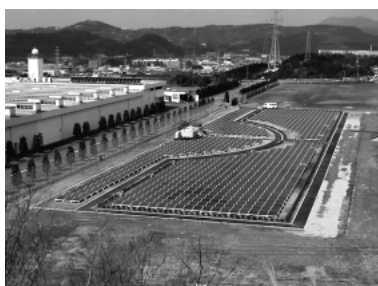
図1 公共・産業用コンクリート架台一体型太陽電池適用例 (110 kW システム)
