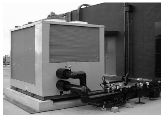
図6 ヒートポンプSシリーズの外観 ヒートポンプSシリーズのMTSH175の単機外観。
