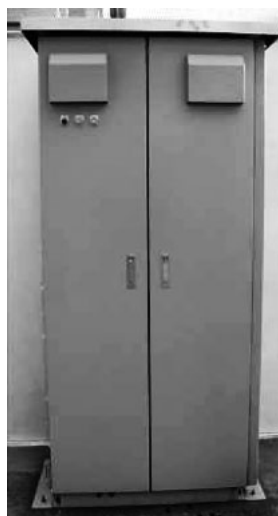
系統連系した 24 kWh 級電力貯蔵システム (左) で長期耐久性を検証中。(右) 270Wh 単電池
