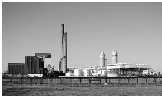
ガス焼き 800 MW × 2 系列 米国初の G 型コンバインドサイクルプラント
