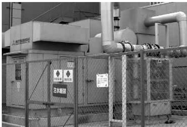
図12 黒煙除去装置設置状況 高硫黄燃料においても黒煙を除去できる。
