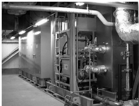
図6 稼働中のGS12R-M ミラーサイクルの適用により従来に比較し大幅な熱効率改善を達成している。
