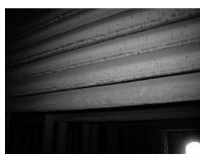
火炉出口位置2次過熱器下部
