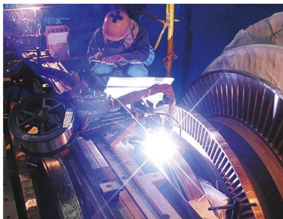
図2 実機地熱ロータの補修溶接作業状況
