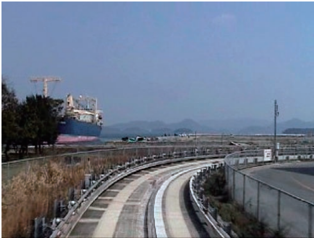
図8 小曲線走行中の車内からの風景
