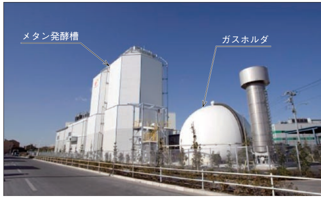
図2 食品リサイクル施設外観 メタン発酵槽にて発生したバイオガスはガスホルダ経由でガスエンジン、燃料電池などに有効利用される。
