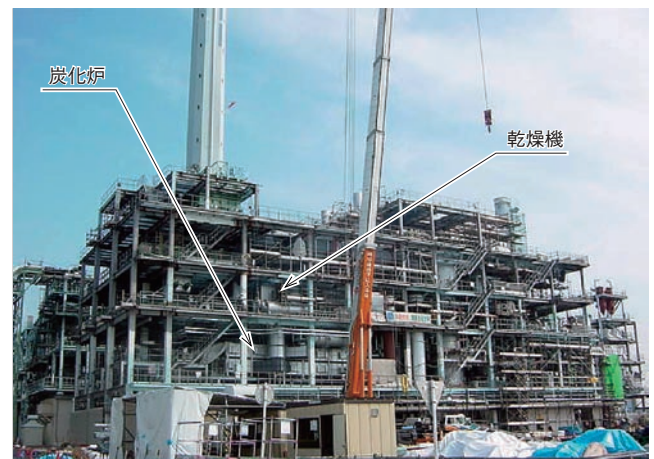
図5 下水汚泥炭化施設外観 下水汚泥炭化施設は現在建設中であり、平成19年内に完成予定。
