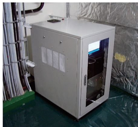
図2 システム搭載例 パソコンや計装機器類を専用ユニットにまとめて本船のブリッジに搭載する。
