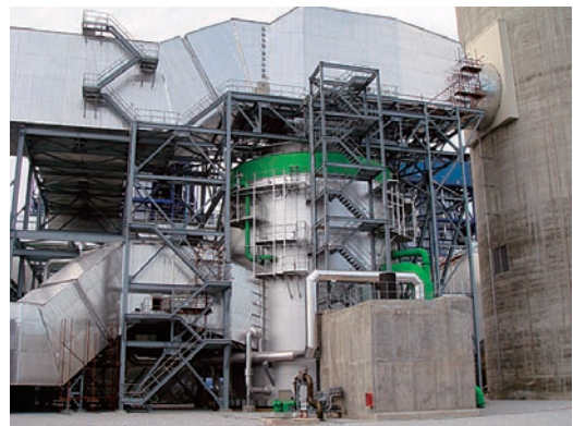
図 7 海水式脱硫設備 (吸収塔)
