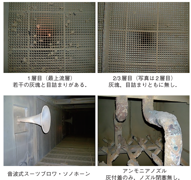
図9 脱硝装置内部点検
