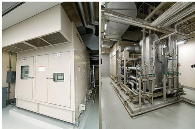
図6 稼動中のアドバンストミラー GS6R-305kW 温水回収仕様
