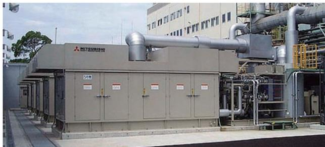
図4 稼動中のアドバンストミラー GS16R-815kW 蒸気+温水回収仕様
