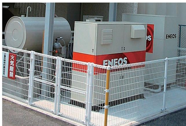
図4 灯油焼き 10kW 級 PEFC システム
