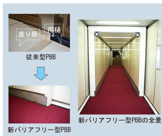
図2 トンネルと床板接続部
