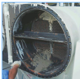
図4 凝縮器ブラシ洗浄例
