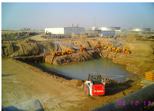
図4 土工工事 地下水汲み上げ排水
