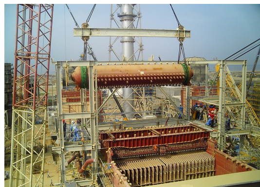
図5 機械工事 ボイラドラム上げ
