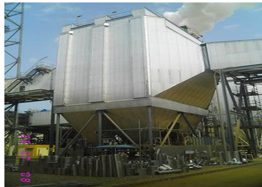
図7 電気集塵機
