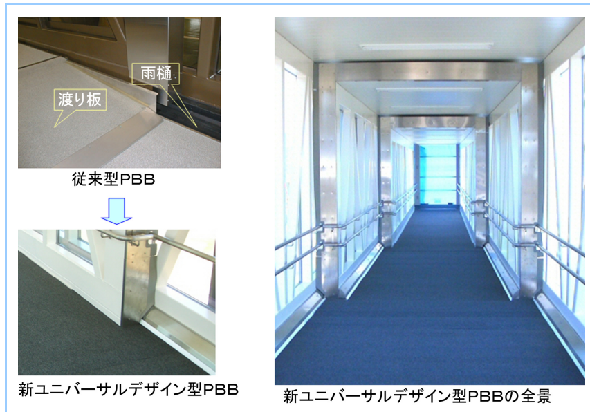
図2 トンネルと床板接続部
