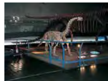
手すりのかさ上げ
