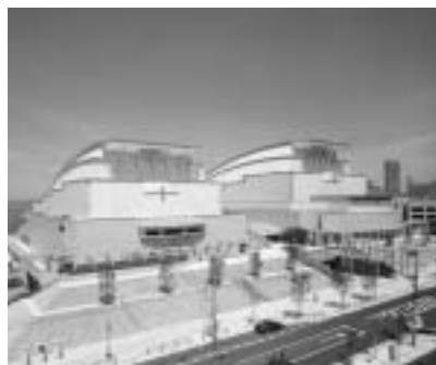
▲びわ湖ホール(外観)
