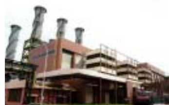
ガンダール火力発電所
