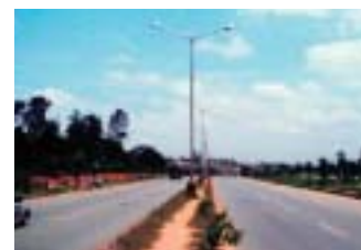
道路照明の点灯・消灯作業を自動化
