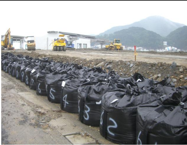
女川漁港 水揚げ岸壁嵩上げ状況 (6/2)
