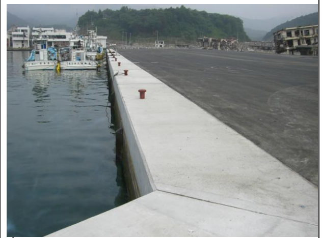
岸壁嵩上げ，舗装工事後 (6/14)
