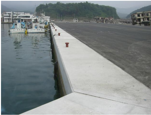
女川漁港 岸壁嵩上げ，舗装工事後 (6/14)
