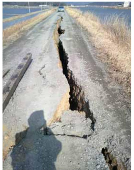
真野川堤防の亀裂
