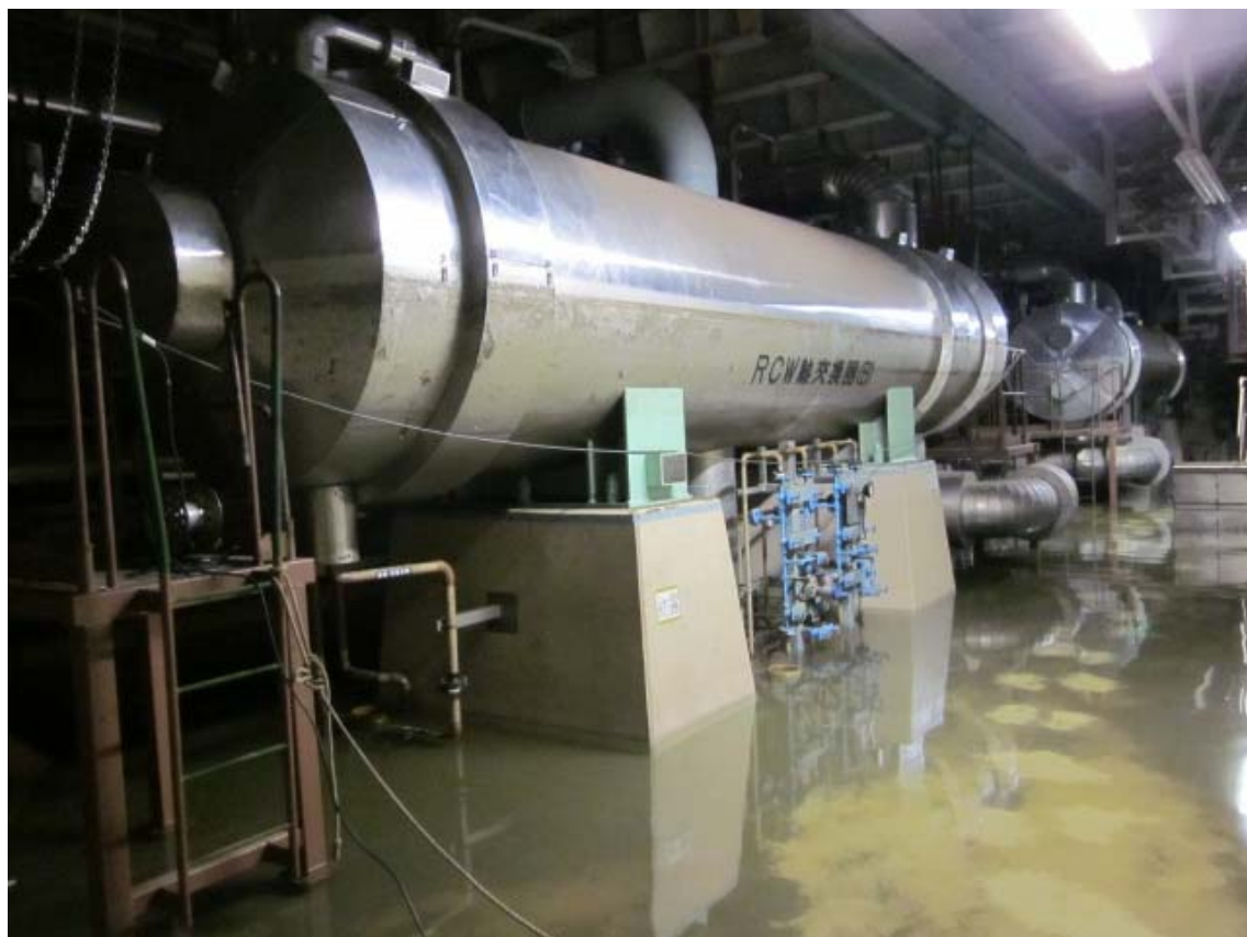
R C W熱交換器（B）室における海水の浸水状況
