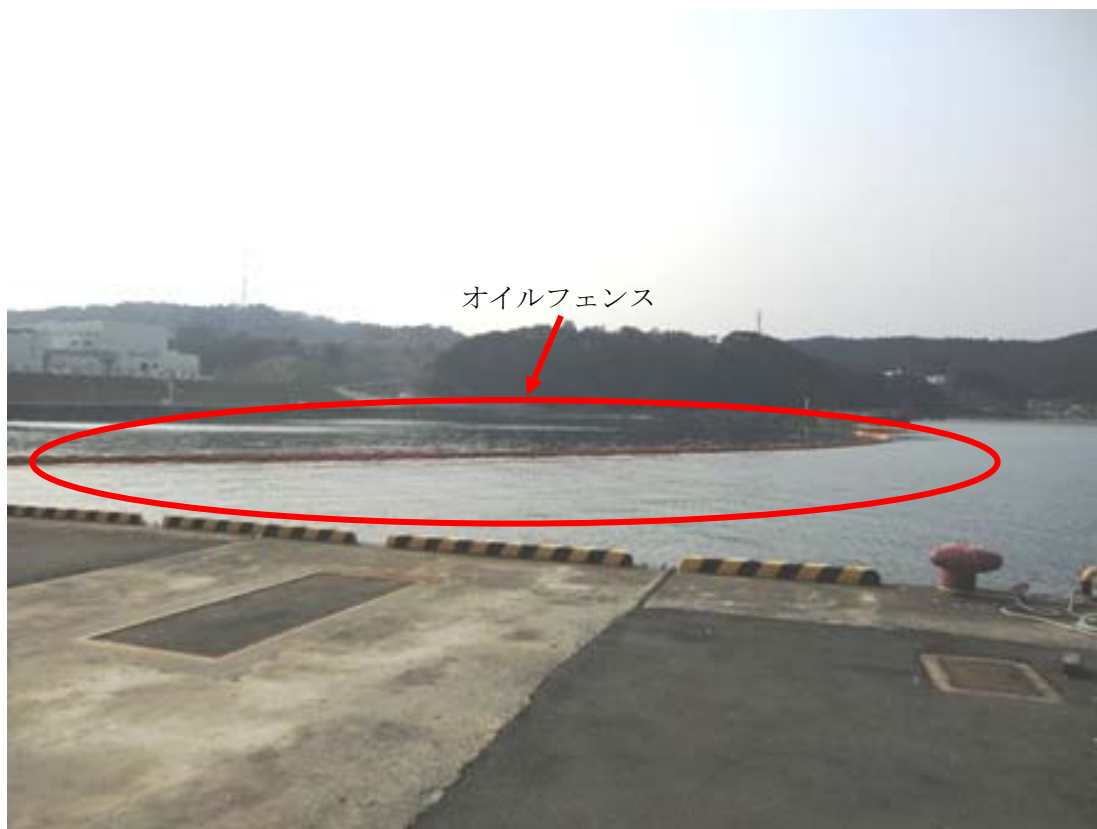
オイルフェンス設置状況
