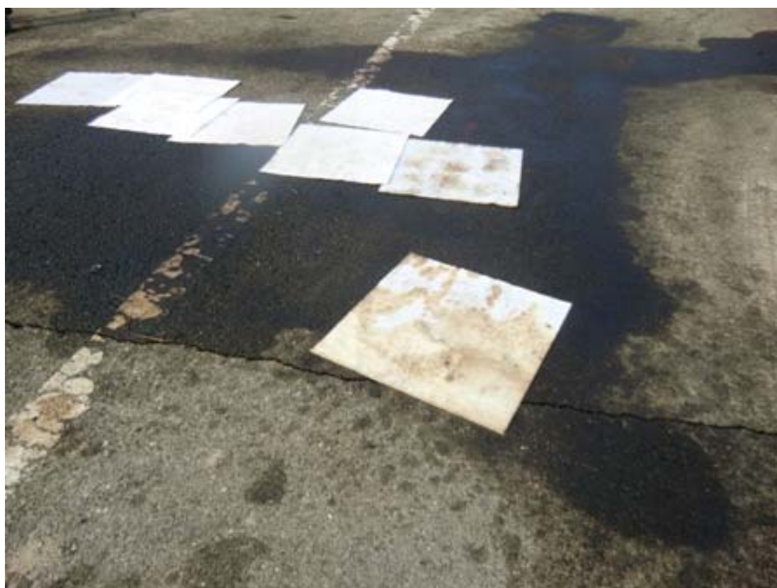
吸着マット設置状況
