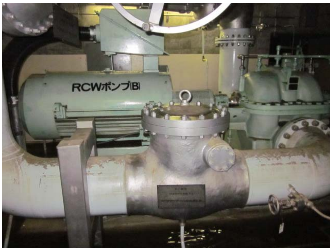
R C Wポンプ（B）（海水抜き取り後）
