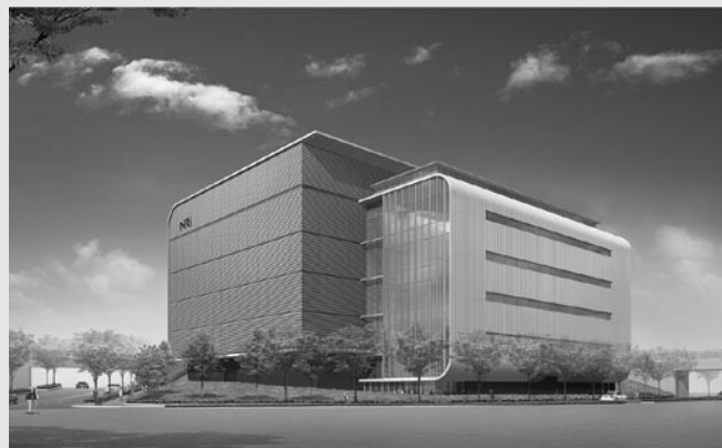
図2 NRIの横浜第二データセンター
