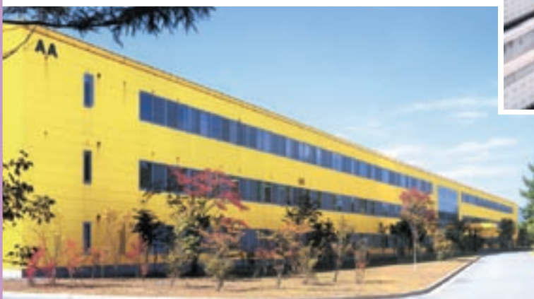
ファナック㈱中央テクニカルセンター外観
