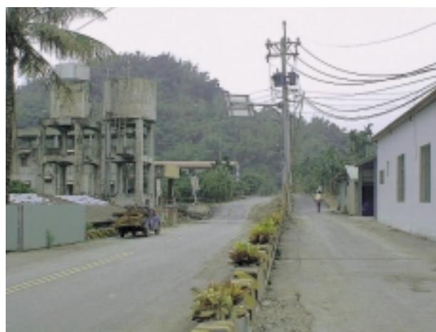
1999年台湾・集集地震による地震断層近傍の状況。断層変位は道路の坂として認められる。断層近傍の給水タンクや建造物に顕著な被害は認められない。
