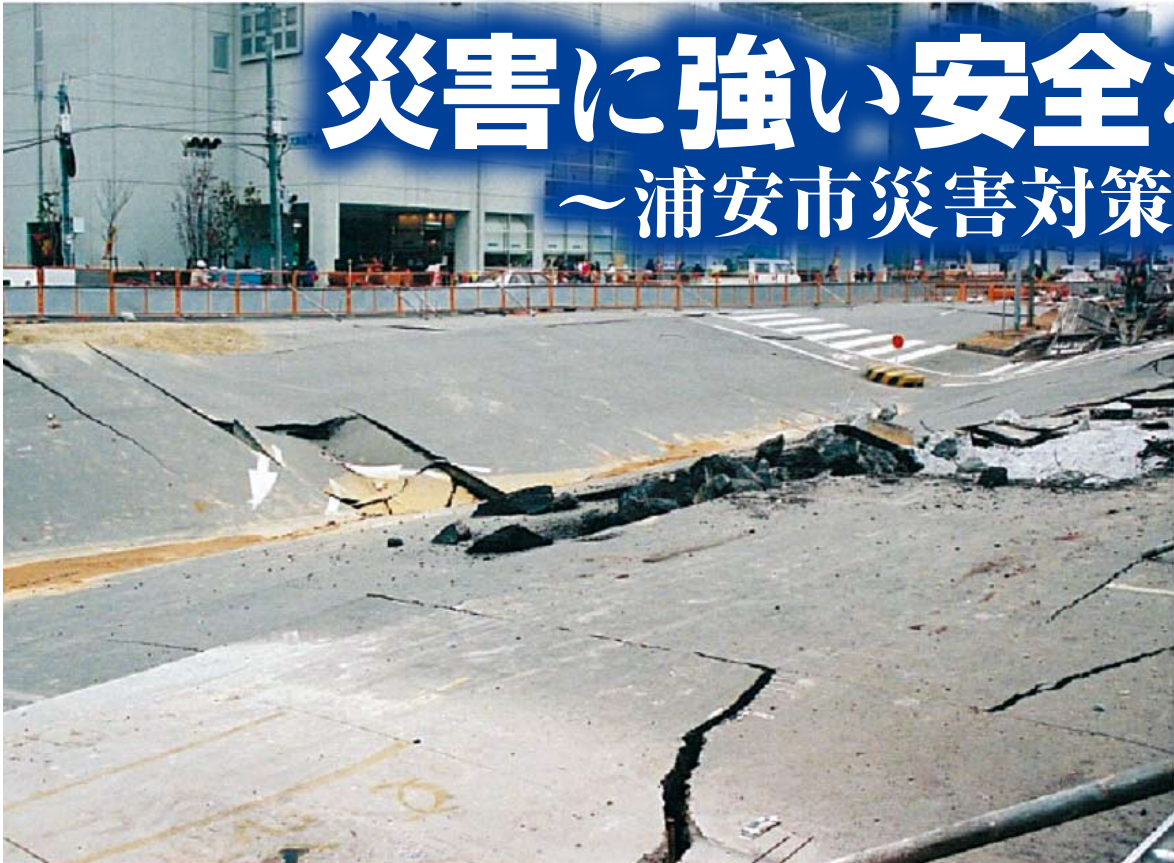
①液状化現象によって陥没した道路（阪神・淡路大震災）
