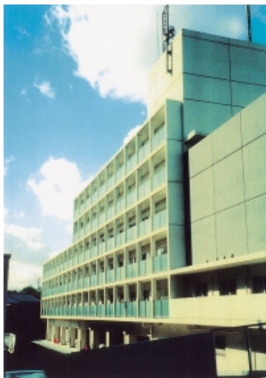
写真 3 : ビル用免震ゴムの交換工事をした 6 階建ビル (大成建設八事寮 (名古屋))
