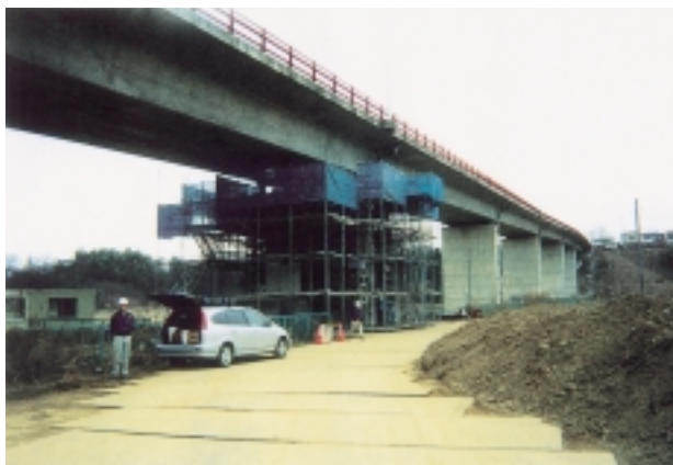
写真 2 : 橋梁用ゴム支承の交換工事 (山あげ大橋, 栃木県)
