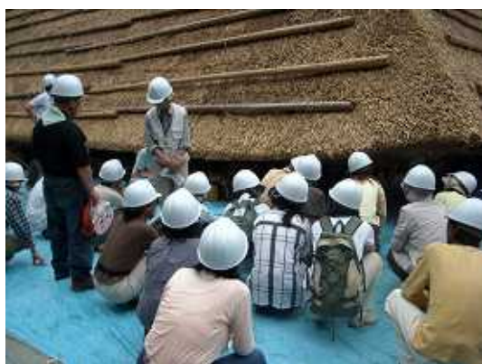
市民への説明（種月寺屋根修理状況）
