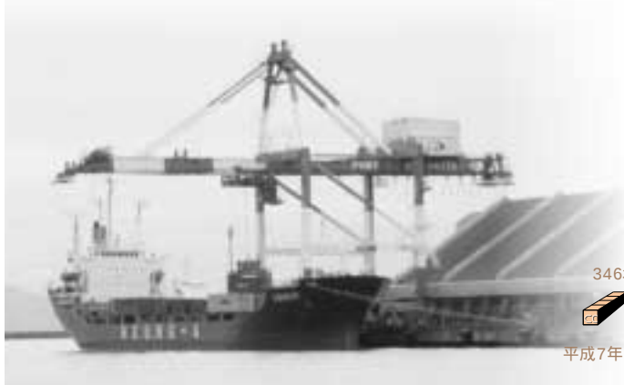
ガントリークレーンとコンテナ船
