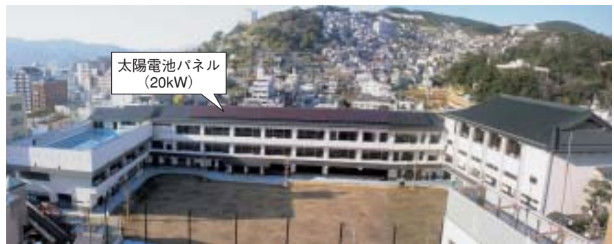
桜町小学校に設置された太陽光発電システム (平成15年度NEDO補助事業)
