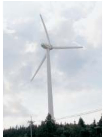
野母崎風力発電所
