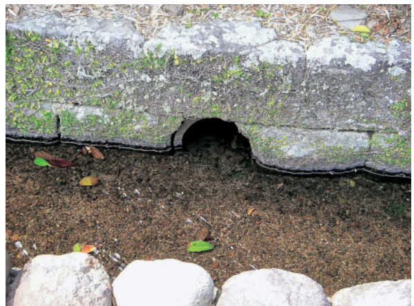
「屋敷内からの水の出口」
