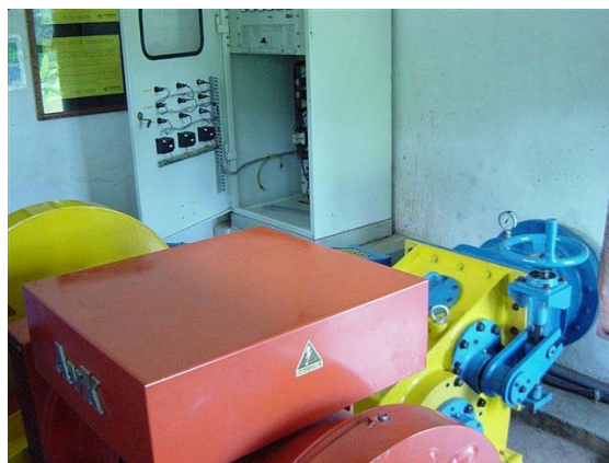
(写真 4) 発電所内部
