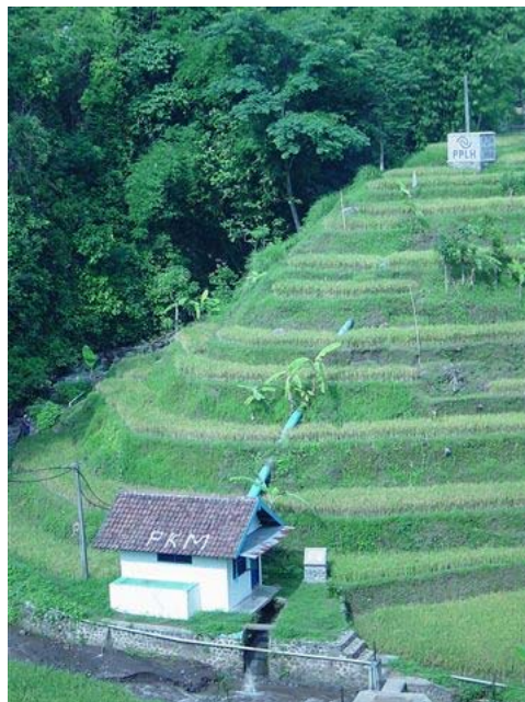
(写真 2) スロリマン発電所全景
