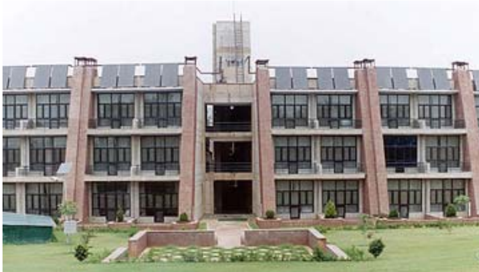
RETREAT の南側：太陽熱温水器とソーラーチムニーが設置されているのが見える
