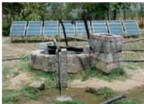
太陽光発電ポンプによる井戸水汲み上げ
