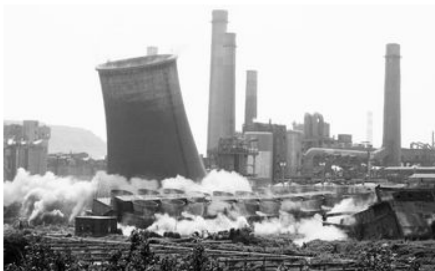
出所：中国経済網（中国五大電力会社華電集团公司に所属するズウボウ熱電併給型発電所での爆破による冷却塔の解体。このような爆破による発電所解体の光景は随所に見られる）
