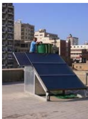
海水や汽水を処理する自立電源式の分散型太陽熱脱塩プラント
