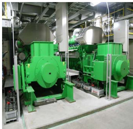
写真 3 : 埋立地ガスによって作動する発電機を動かすレシプロエンジン(米国 GE 社のイエンバッハ・ガスエンジン「タイプ 6」) - GE 社提供)
