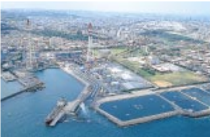
沖縄電力牧港火力発電所
