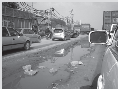
NH8（デリー～ムンバイ間幹線道路）で 車線を横断する未完成・未舗装区間
