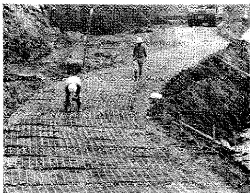
図 1 CFGFRP 複合材料の使用例 (土盛り)
