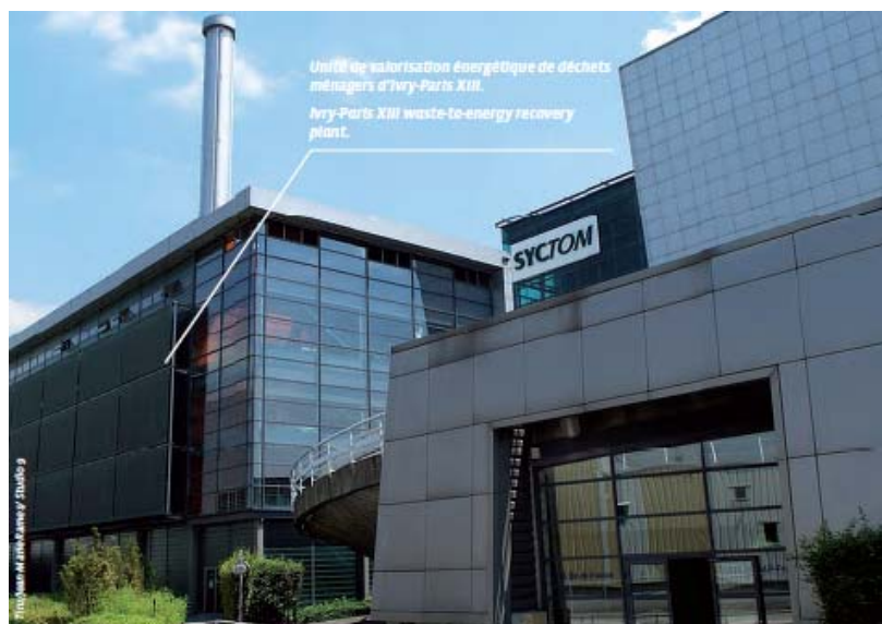
Ivry-Paris XIII 廃棄物—エネルギー回収プラント
