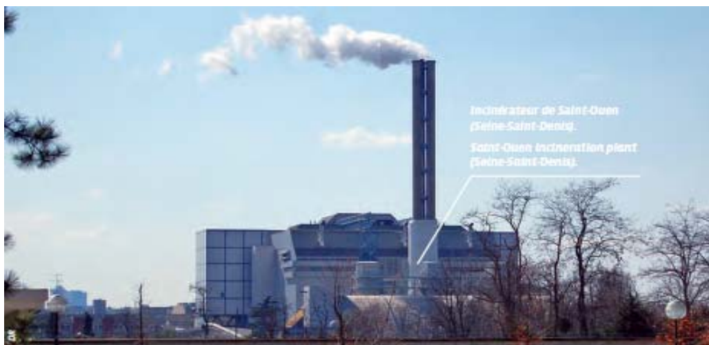
Saint-Ouen 焼却プラント（Seine-Saint-Denis、フランス）
