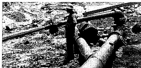
掘って、崩して……
