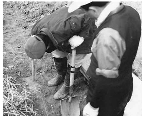
第1回活動 水系・ばか棒による高さの調節作業
