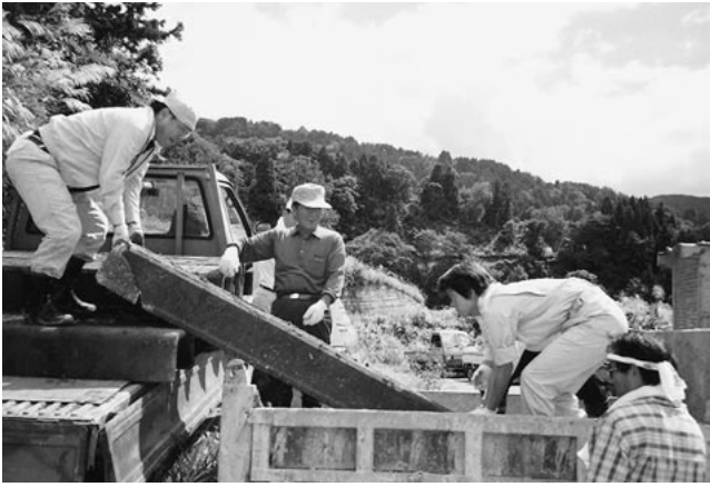
第4回活動 ベンチフリューム積込運搬作業
