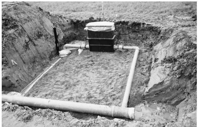
写真 - 1 給排水ユニットと用水パイプラインの接続状況
